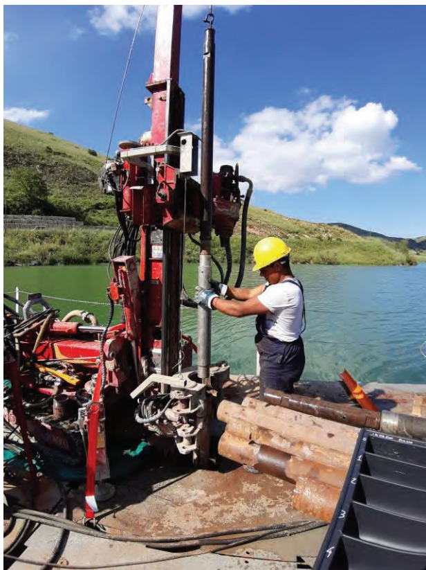
Foto 7: Tentativi di prelievo dei campioni indisturbato con campionatore Osterberg
